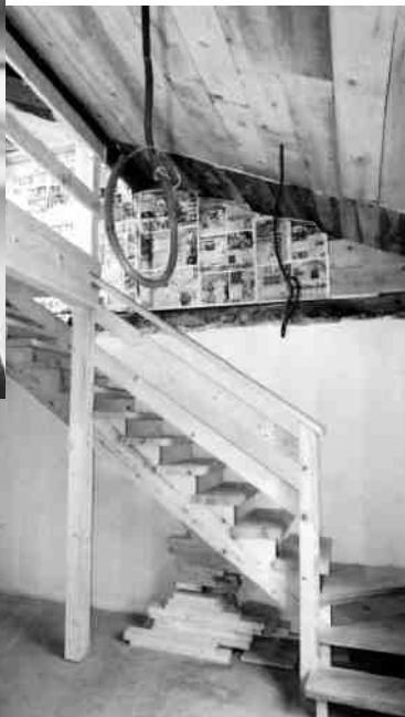
Renovationsarbeiten für das Atelier Diversis
